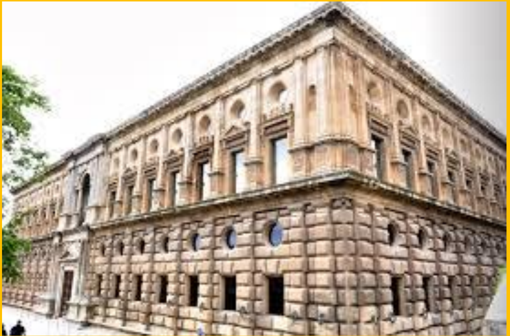
Exterior palacio Carlos V
